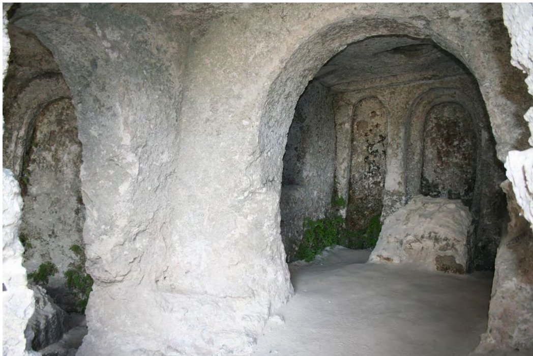
Figura 13 interno chiesa di S. Vito alla M.
